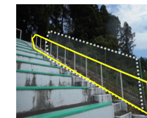
1Bブロック設置禁止箇所
